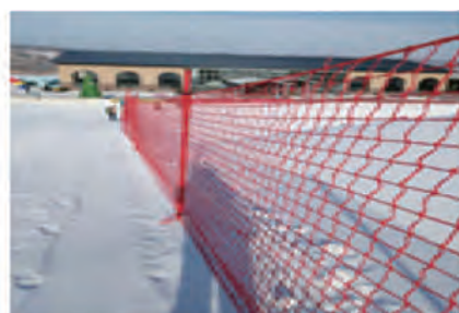
安全防护设施
